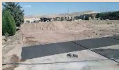
تبریز - قسمت بتونریزی شده مزار
