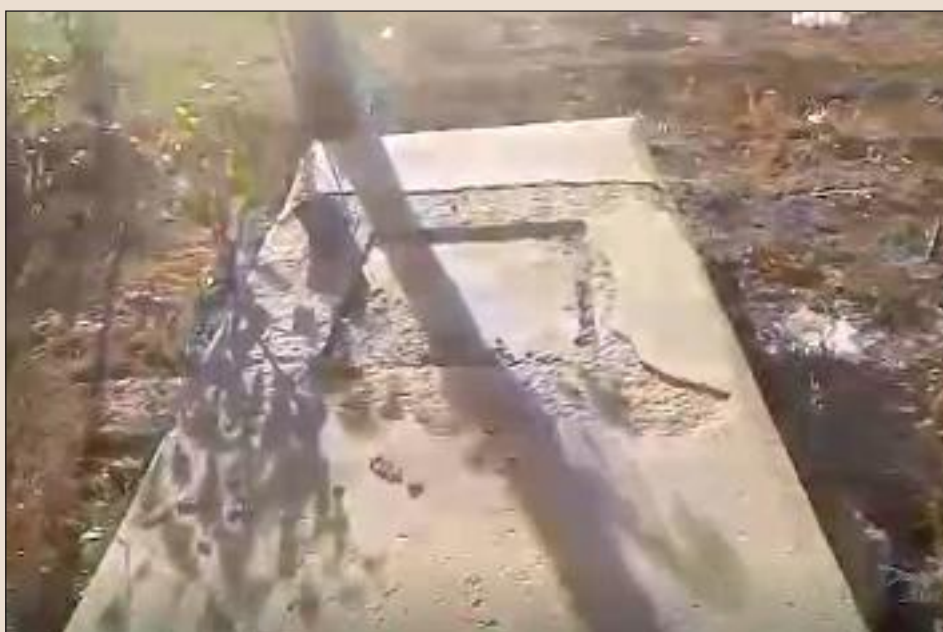
قوچان - یک مزار تخریب شده
