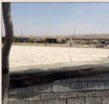
تبریز - مزارهای بتونریزی شده
